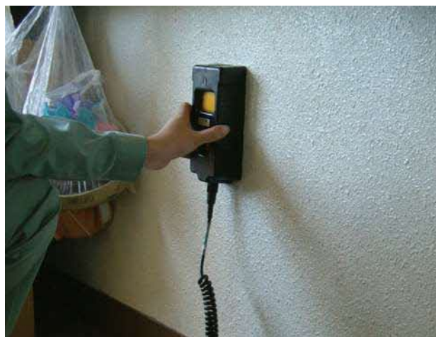
配筋調査(鉄筋探査状況)
