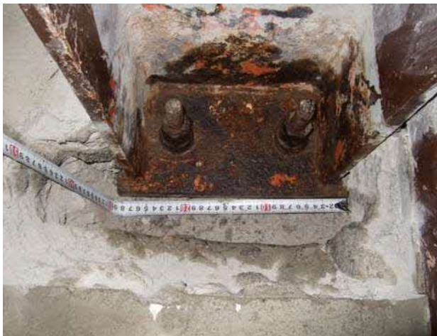
柱脚部調査(接合、発錆状況)
