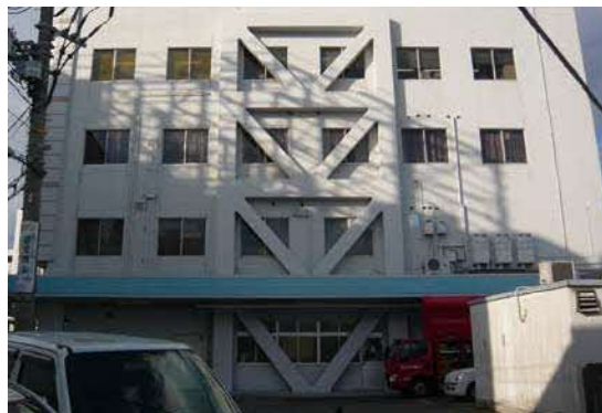
外部鋼管ブレースによる補強
