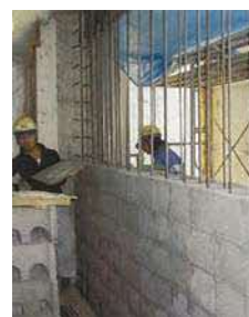
低振動・騒音、省スペース施工が可能な工法による耐震壁
