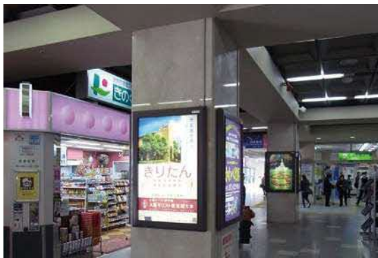
補強した柱を広報スペースに活用
