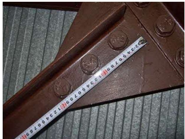
ブレース接合部調査
