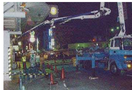
夜間に工事を実施し営業を継続
