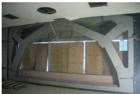
鉄骨ブレースによる壁補強
