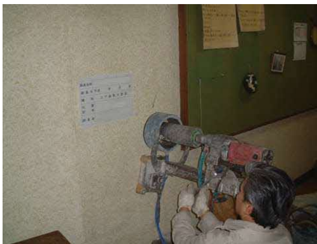
コンクリートコア抜き状況
