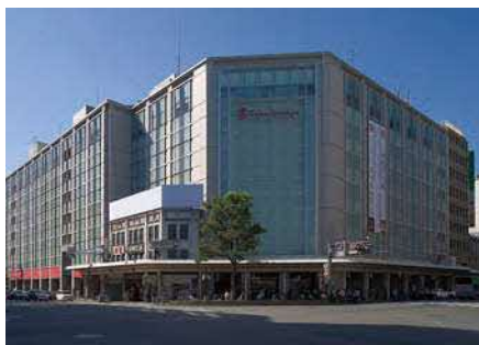
設計時の意匠を生かしつつ、フレーム補強にあわせてガラスを多用し明るい雰囲気
