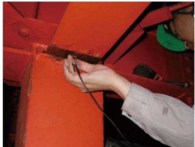
溶接接合部調査(UT試験状況)
