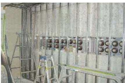
ブレーキダンパーによる制震システム
