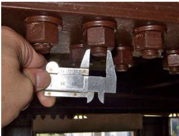
高力ボルト径測定調査
